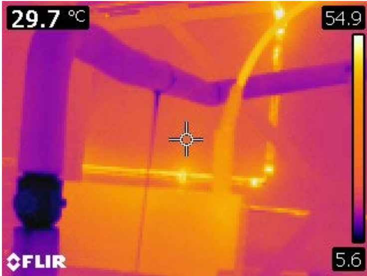
Равномерная изоляция трубопровода
