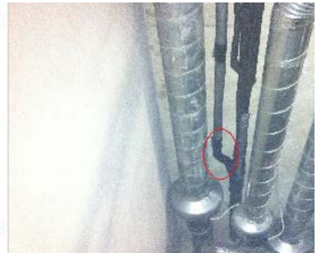
Дефект в изоляции трубопровода
