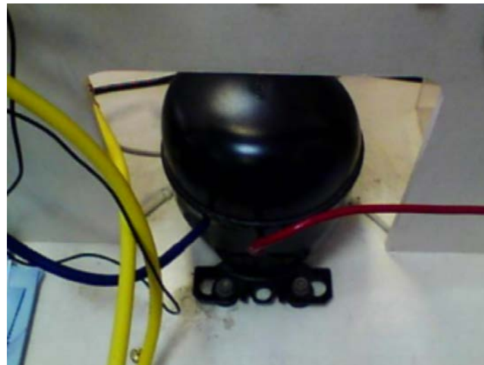
Компрессор бытового холодильника
