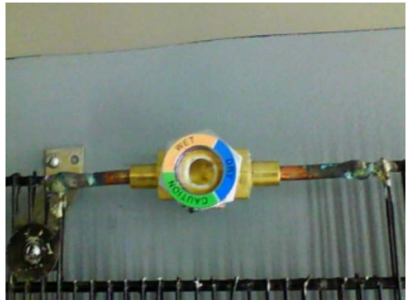
Отсутствие утечки фреона в местах пайки (смотровой глазок)
