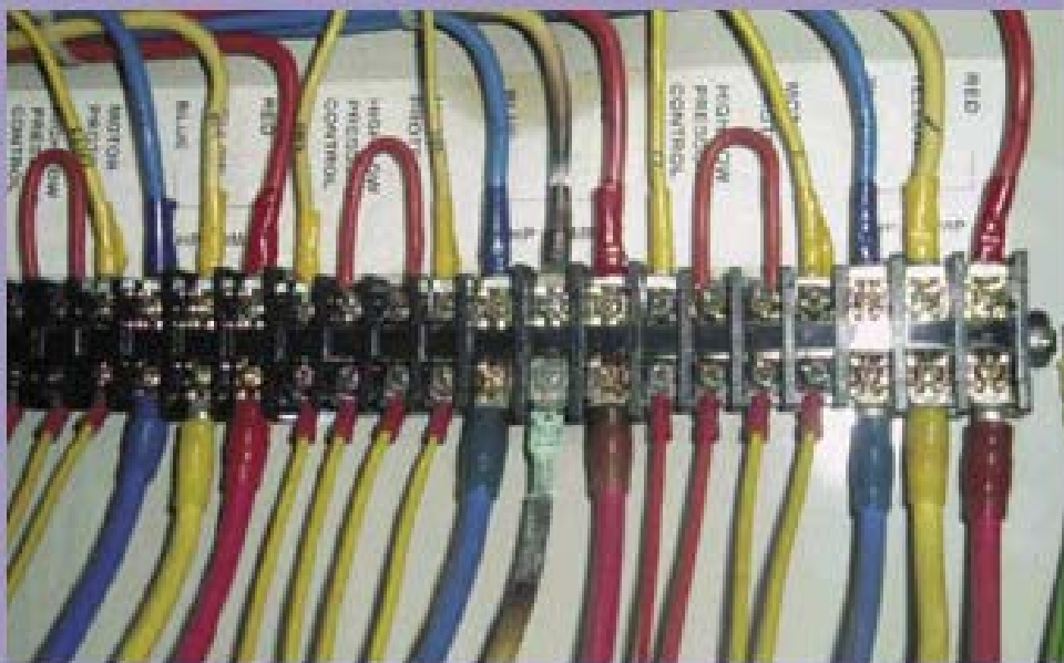
Проверка нагрева проводов
