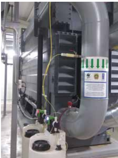
АБСОРБЦИОННАЯ ХОЛОДИЛЬНАЯ МАШИНА (АХМ) — ЦЕНТРАЛЬНЫЙ ЭЛЕМЕНТ ЭНЕРГОКОМПЛЕКСА. ФОТОГРАФИЯ ПРЕДОСТАВЛЕНА: ВАЛЕРИЙ ПИЩИК.
