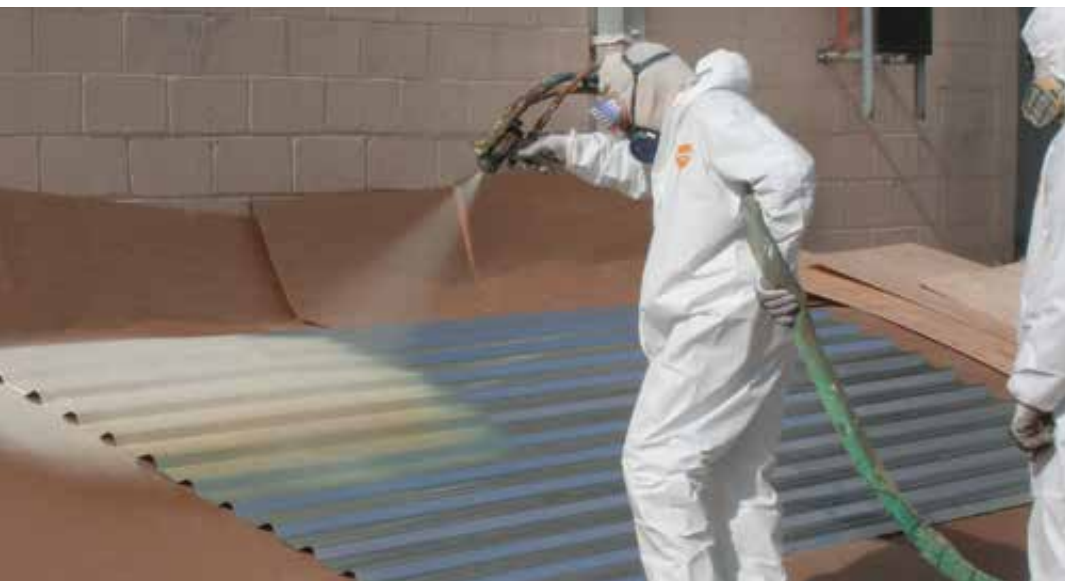
ИСПЫТАНИЯ ПЕНОРАСПЫЛЯЮЩЕЙ УСТАНОВКИ В УРЕТАНОВОЙ СИСТЕМОТЕХНИЧЕСКОЙ КОМПАНИИ В МЕКСИКЕ. ФОТОГРАФИЯ ПРЕДОСТАВЛЕНА: ГОРАЦИО ЭРНАНДЕС ДЕЛ КАСТИЛЬО.
