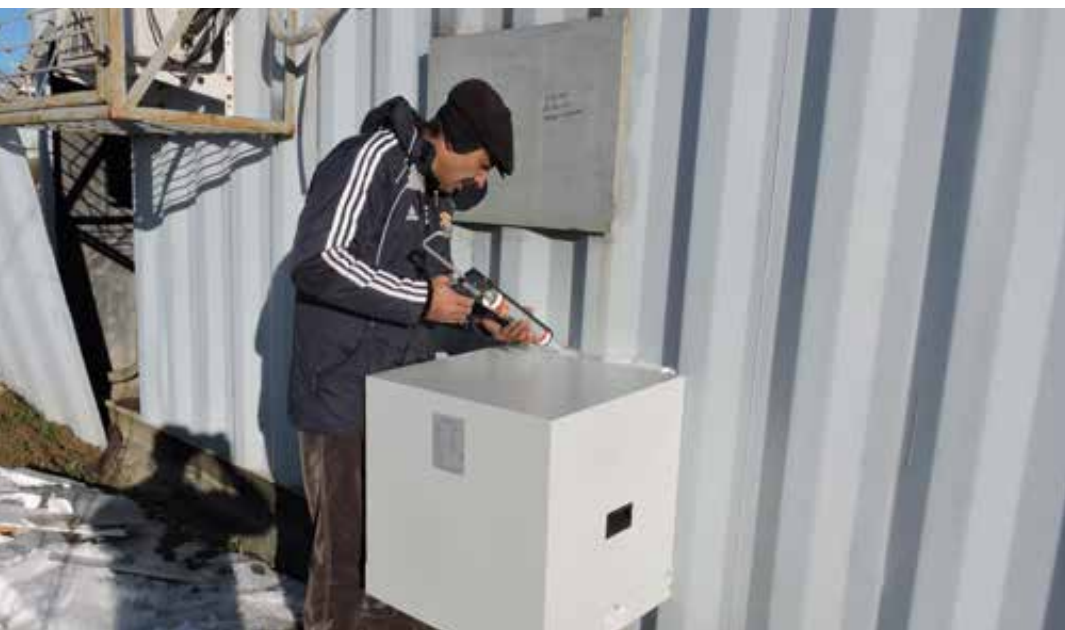
МОНТАЖ ЭНЕРГОЭФФЕКТИВНОГО МОДУЛЯ ОХЛАЖДЕНИЯ НА БАЗОВОЙ СТАНЦИИ МОБИЛЬНОЙ СВЯЗИ. ФОТОГРАФИЯ ПРЕДОСТАВЛЕНА: ПРООН-ТАДЖИКИСТАН.
